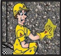
**3** Aplique el puente de adherencia con cepillo, rodillo o brocha, frotándolo sobre la superficie preparada y coloque el mortero antes de que el puente de adherencia seque.
