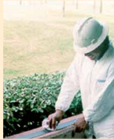
Limpieza del laminado con Sika Colma Limpiador y un trapo blanco hasta que quede libre de polvo u otros contaminantes.
