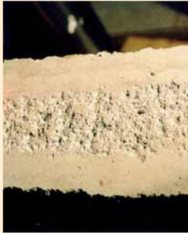
Preparación del soporte: limpieza de partes sueltas y lechadas superficiales, así como regularización de zonas donde no se cumpla la tolerancia de planeidad (ver Hoja de Datos de Producto)
