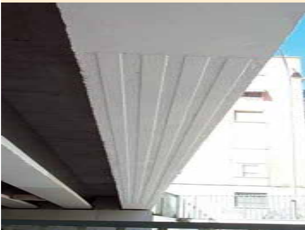
Terminación estética de refuerzo a flexión en viga de puente.
