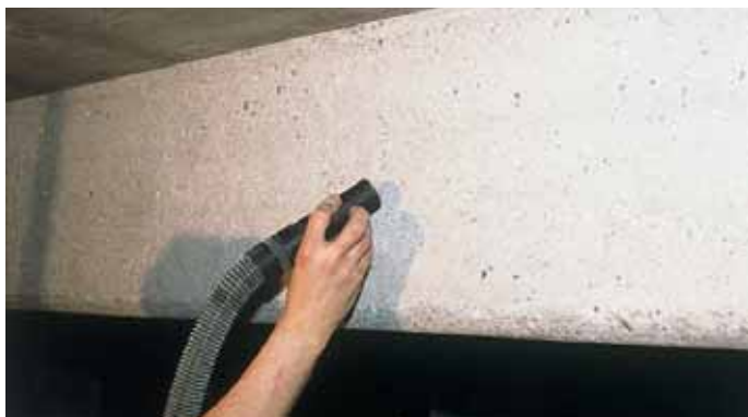
Preparación del Soporte de Hormigón
