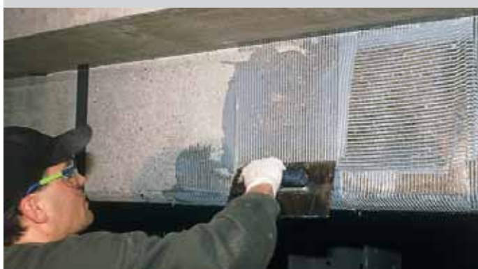
Aplicación de la mezcla SikaDur-330® sobre el Soporte Preparado
