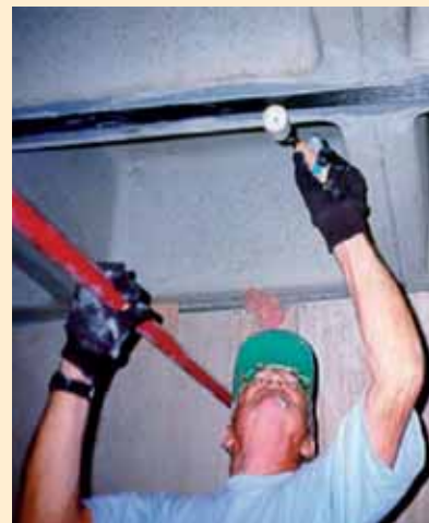
¡Muy importante! Presionar con rodillo hasta que la resina rebose por ambos lados y no queden burbujas de aire entre el laminado y el soporte.
