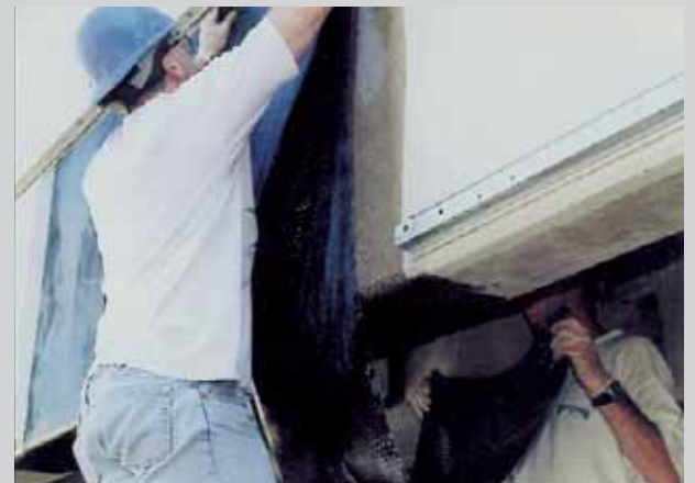
Aplicación del Sistema SikaWrap® en el refuerzo a cortante de una viga
