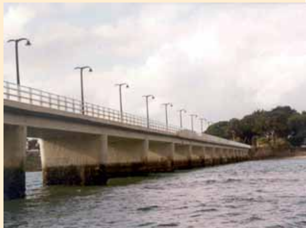
Puente sometido a proceso de reparación por corrosión de armadura y refuerzo por pérdida de sección en las mismas.
