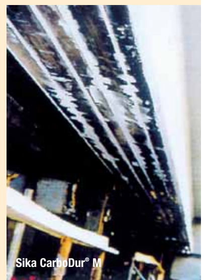
Viga de hormigón reforzada
