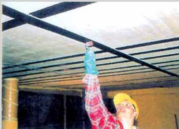
Refuerzo de hormigon armado con laminados Sika CarboDur®
