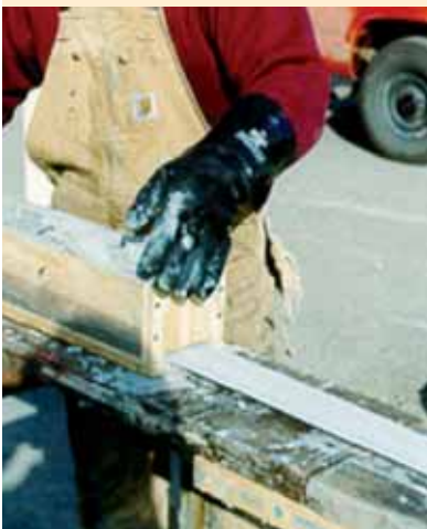
Aplicación de resina sobre el laminado (1-2 mm)
