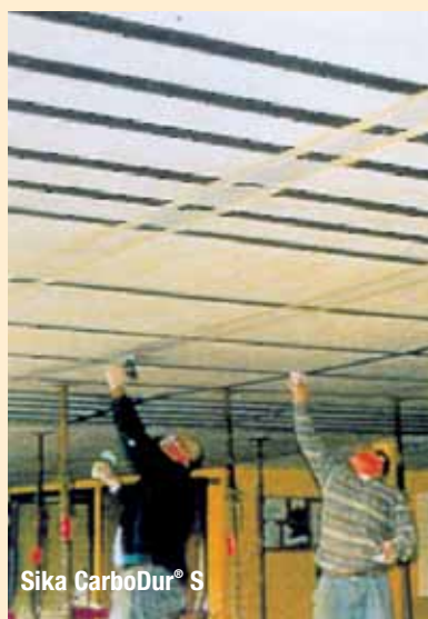
Losa de hormigón reforzada
