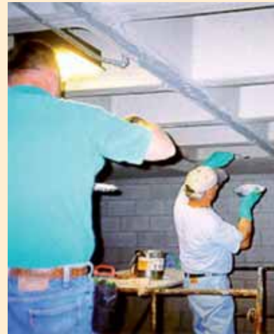
Aplicación de la resina en el soporte (2 mm).
