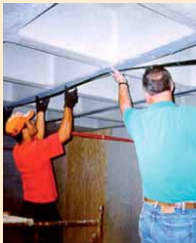
Colocación sobre el soporte. Fácil y rápida sin interferir con otros oficios y sorteando otras instalaciones.
