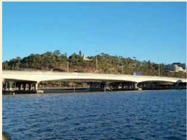
Reparación y refuerzo en tablero de puente realizado desde balsas.
