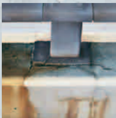
Corrosión del acero de refuerzo evidenciada con manchas de óxido en fisuras causada por soportes de acero galvanizado que fueron fijados al parapeto.
