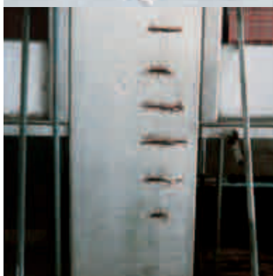
Corrosión electroquímica del acero de refuerzo debido a la reducción de la alcalinidad pasivadora del concreto por carbonatación.
