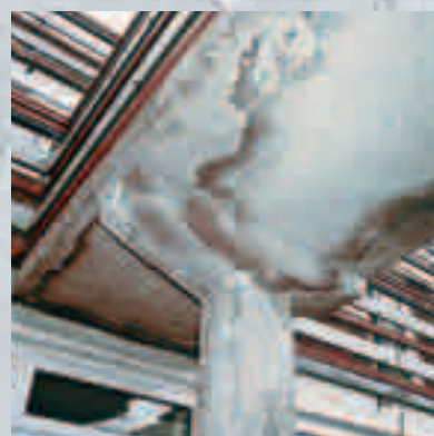
Efectos del daño de corrosión del acero de refuerzo acelerada por el ingreso de cloruros de sales de deshielo.
