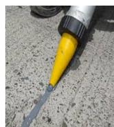
3. Verter o bombear el sellador en la ranura de la junta en una dirección y permitir que el producto fluya y alcance el nivel necesario. Utilice las herramientas requeridas.
